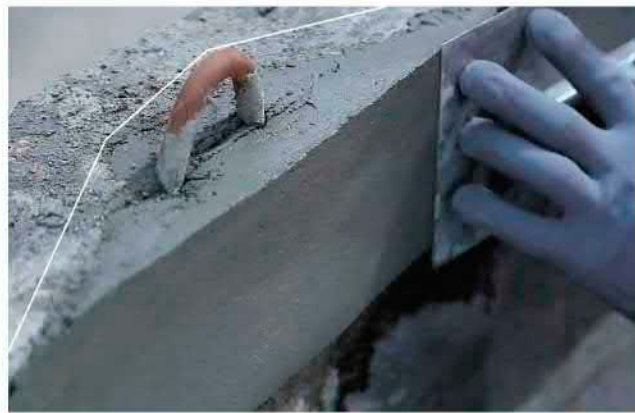
Заливка цементным составом
